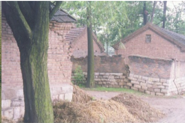
因采煤塌陷造成房屋开裂现状
