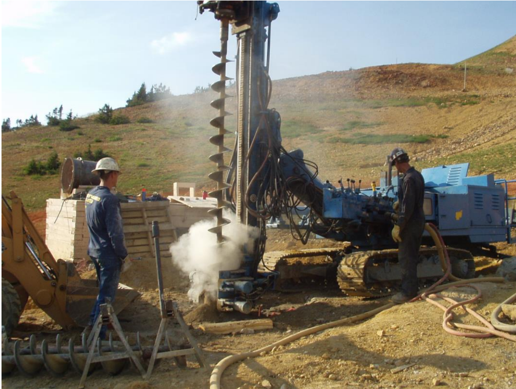
Figure 14. Como Raise collar auger holes for caisson wall.
