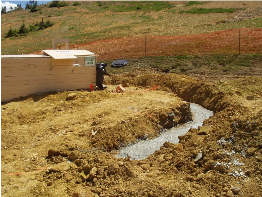
Figure 13. Como Raise collar grout trench.
